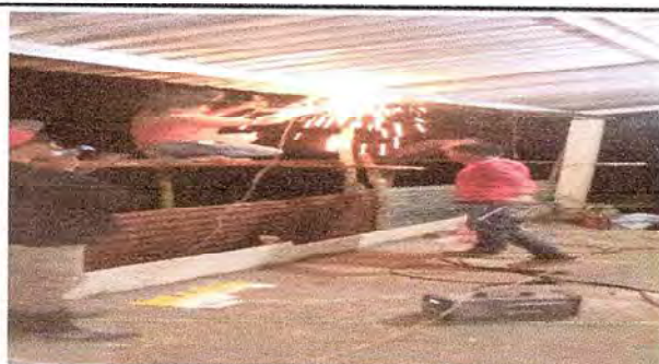
Foto 4: Instalación de canales del establecimiento educativo.
