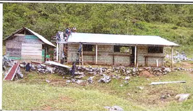
Foto 2: Vista Frontal, donde se observa la instalación de costaneras y láminas troqueladas del establecimiento educativo.
