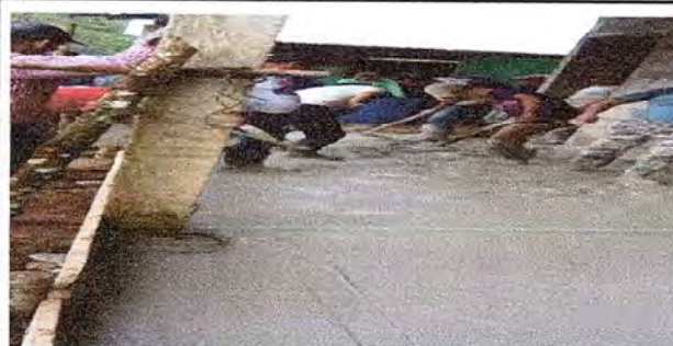
Foto 6: Observándose los diferentes procesos realizados en la remodelación del establecimiento educativo instalación de piso.
